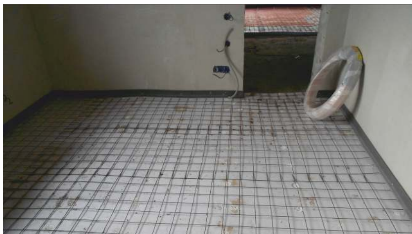
МОНТАЖ АРМИРУЮЩЕЙ СЕТКИ
