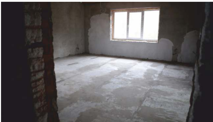
1 ЭТАЖ, СИСТЕМА ЗАЛИТА СЯЖКОЙ
