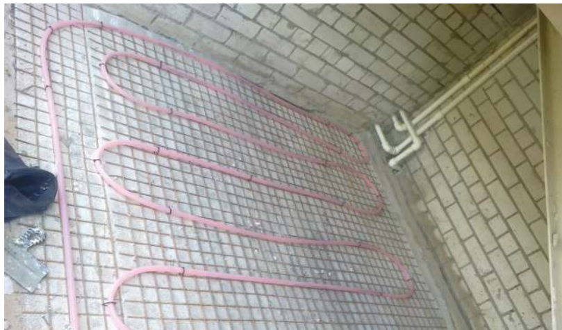
2 ЭТАЖ, МОНТАЖ СИСТЕМЫ
