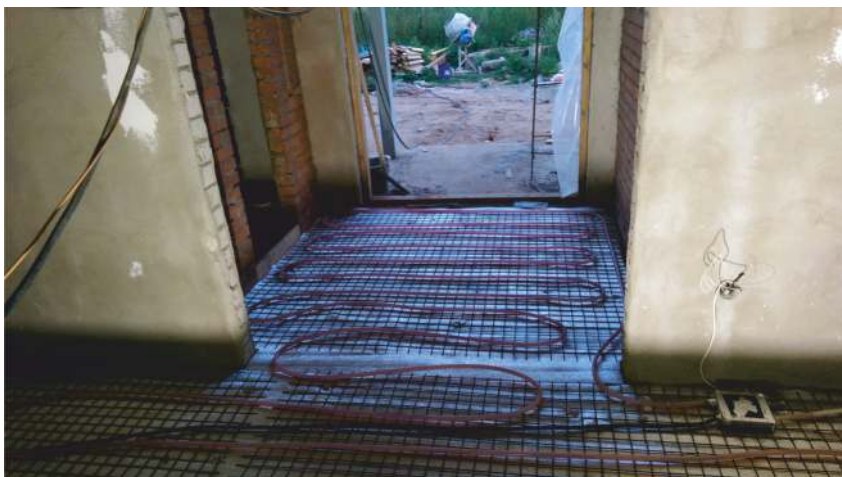
1 ЭТАЖ, МОНТАЖ СИСТЕМЫ
