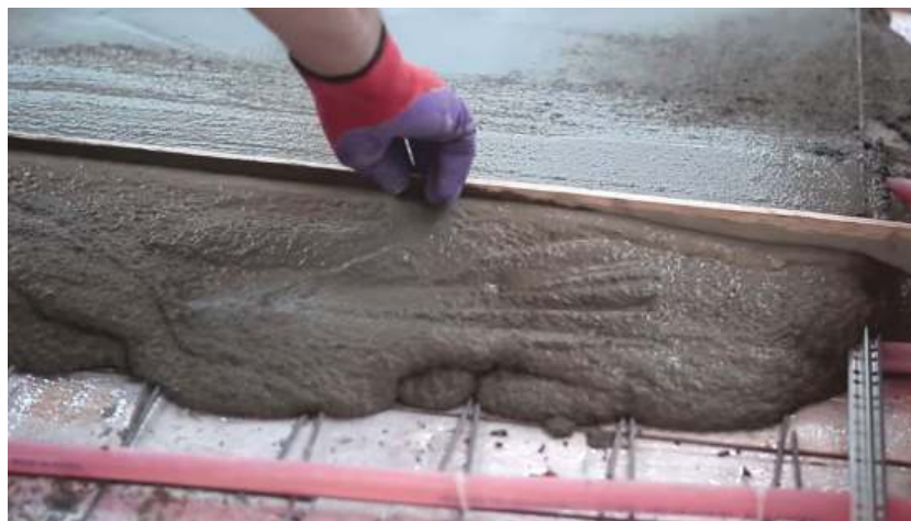
ЗАЛИВКА СИСТЕМЫ СТЯЖКОЙ
