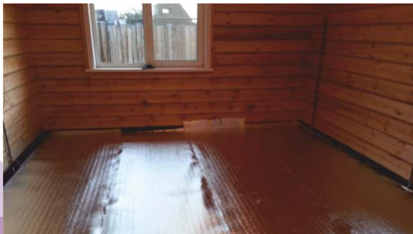
МОНТАЖ ТЕПЛОИЗОЛЯЦИИ
