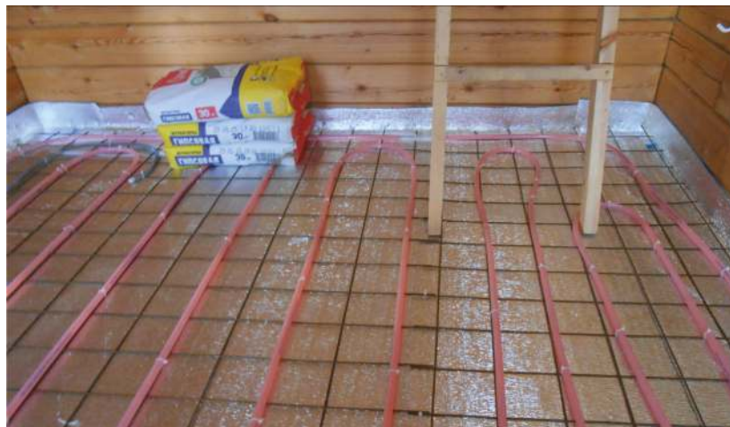
1 ЭТАЖ, МОНТАЖ СИСТЕМЫ
