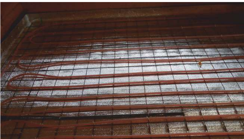
2 ЭТАЖ, МОНТАЖ СИСТЕМЫ
