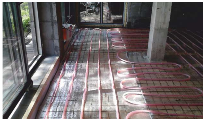
1 ЭТАЖ, МОНТАЖ СИСТЕМЫ
