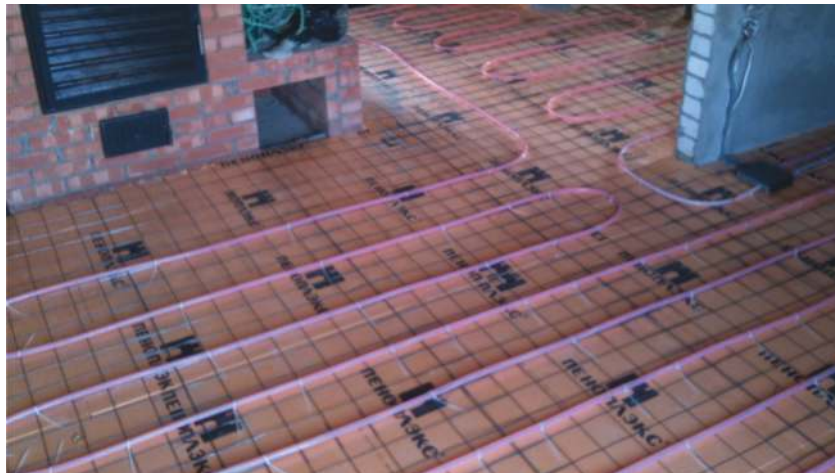
1 ЭТАЖ, МОНТАЖ СИСТЕМЫ
