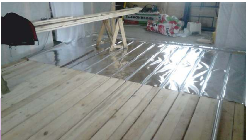
1 ЭТАЖ, УКЛАДКА ПРОМЫШЛЕННОЙ ФОЛЬГИ
