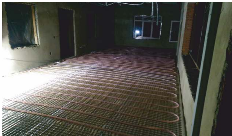
1 ЭТАЖ, МОНТАЖ СИСТЕМЫ
