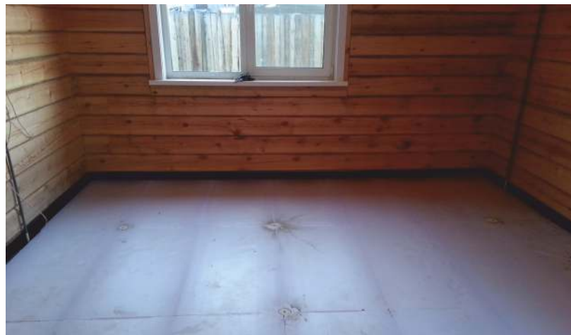
МОНТАЖ ЭКСТРУДИРОВАННОГО ПОЛИСТИРОЛА
