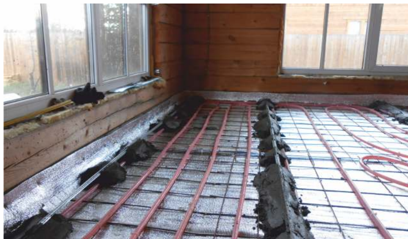
1 ЭТАЖ, ЗАЛИВКА СИСТЕМЫ СТЯЖКОЙ
