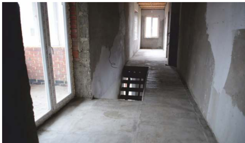
2 ЭТАЖ, СИСТЕМА ЗАЛИТА СЯЖКОЙ
