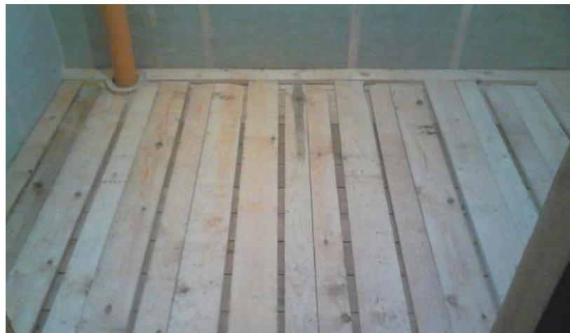
1 ЭТАЖ, МОНТАЖ ДЕРЕВЯННЫХ ЛАГ
