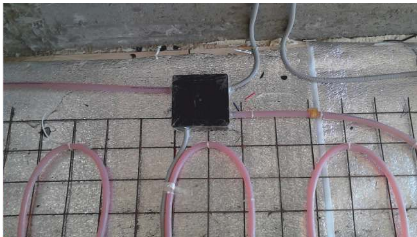
1 ЭТАЖ, МОНТАЖ СИСТЕМЫ
