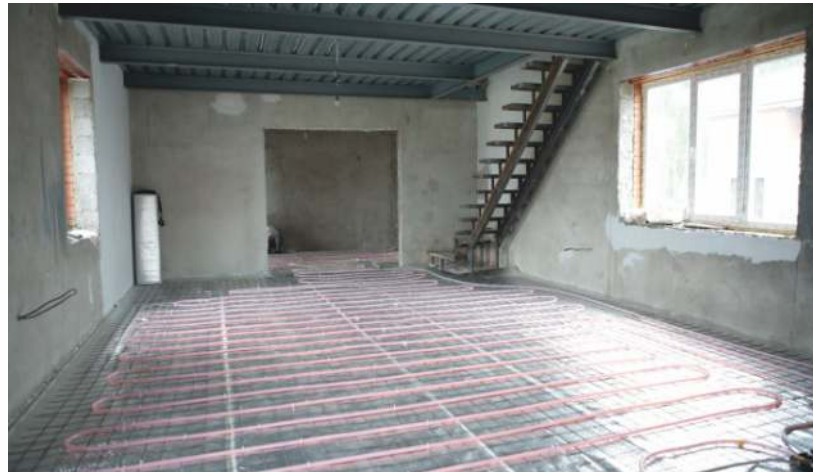
1 ЭТАЖ, МОНТАЖ СИСТЕМЫ
